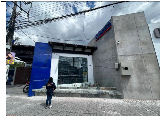
Imagen No. 2: fachada frontal
