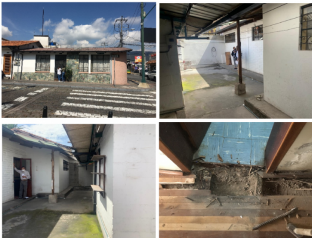
Fotografías del inmueble derrocado en predio Nro. Fuente: Memoria técnica del proyecto
