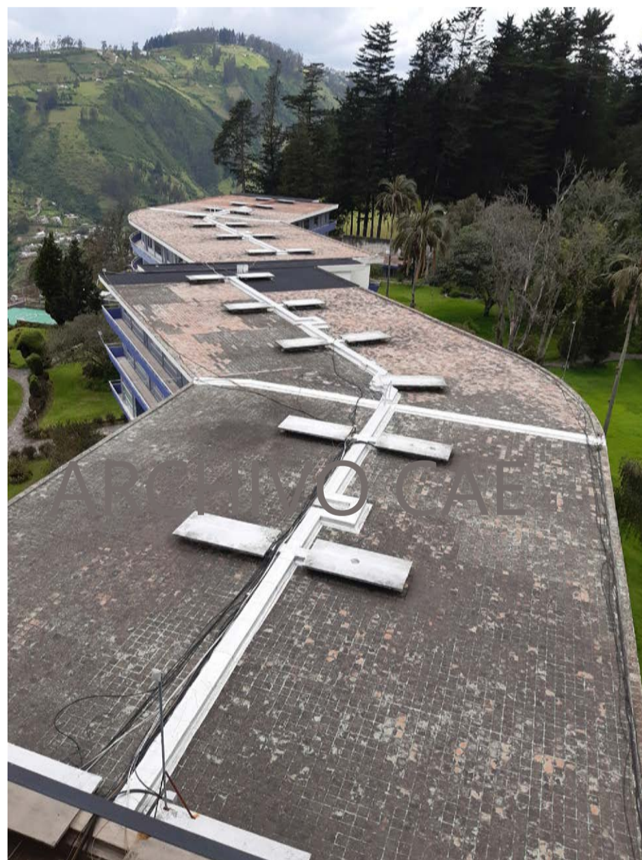
Estado actual del ala sur (2021).
