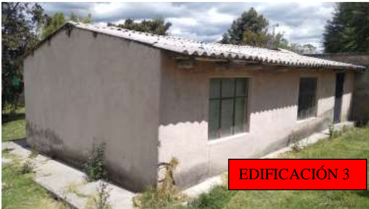
F.6 Edificación 3 existente, estructura de ladrillo portante cubierta de madera revestida de eternit, se usa como bodega.
