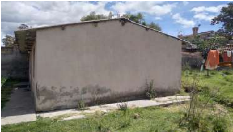
F.7 Edificación 3 existente
