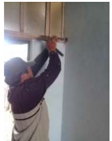
F.3 Muestreos realizados en el sitio, para determinar las condiciones de las estructuras de soporte existentes en las edificaciones
