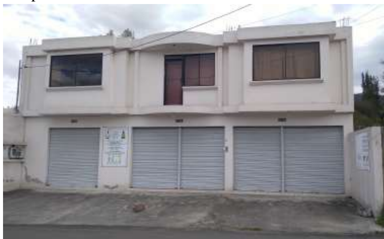
F.4 Edificaciones existentes estructura de hormigón armado óptimas condiciones
