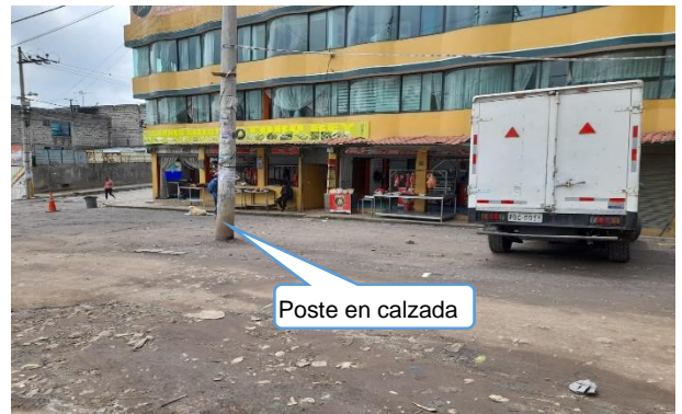
FOTO 8: "PRESENCIA DE POSTES DE LUZ EN LA CALZADA"
