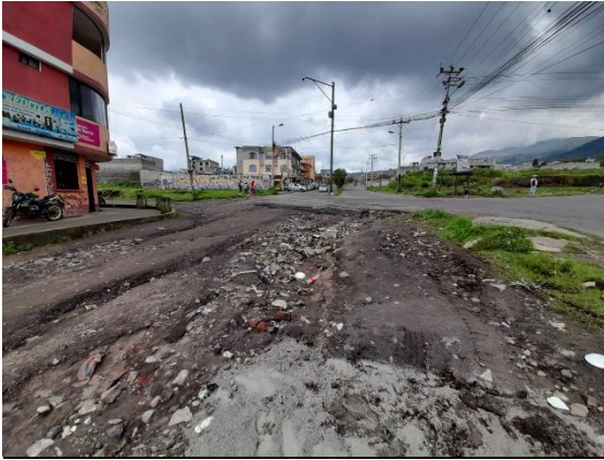
FOTO 1: "ABSCISA 0+000, INTERSECCIÓN CALLE ISAAC CHIRIBOGA"
