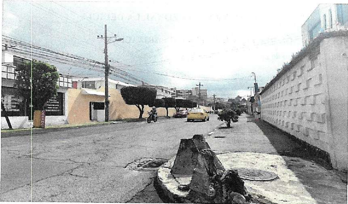
Vías consolidadas, AHHyC con más 50 años de existencia, cuyas secciones viales evidencian la falta de planificación urbanística
