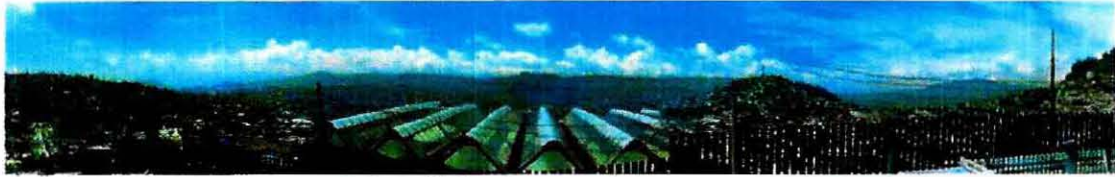
Vista desde la Planta de Tratamiento de Agua "El Placer"
