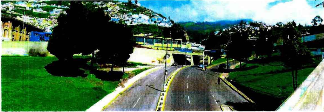
Intersección Av. Mariscal Sucre y Av. 24 de Mayo
