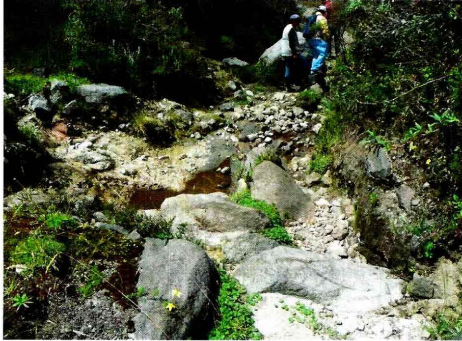
Fig. 18. Erosión lateral en quebrada agravada por el cruce frecuente de personas. Sector Cruzloma Foto: X.Izurieta 2012
