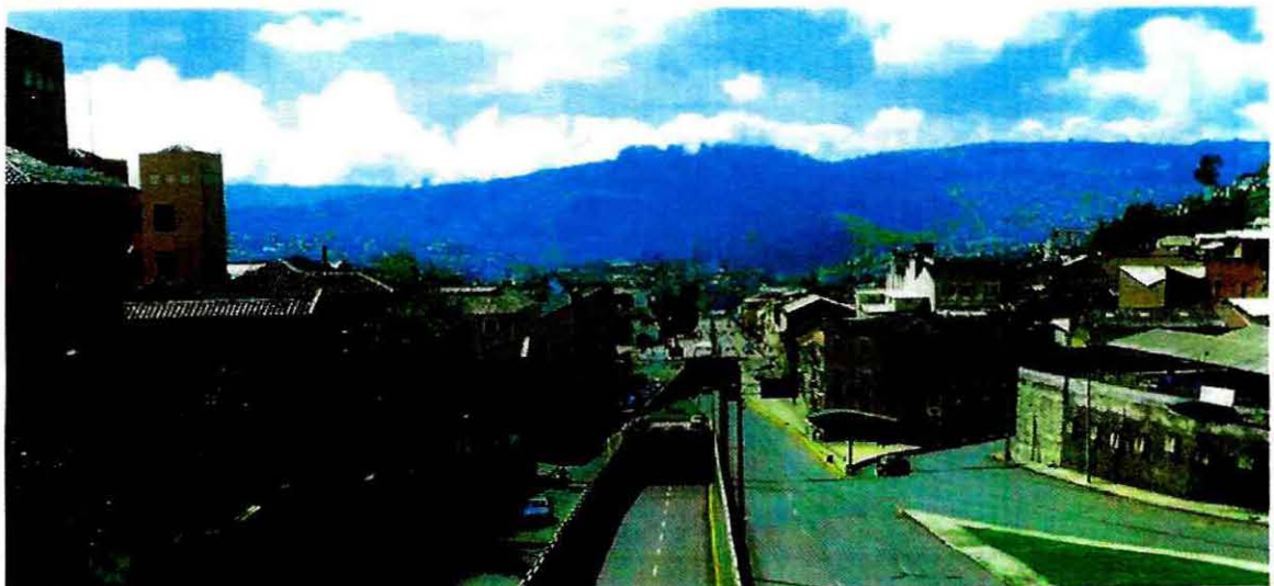
Intersección Av. Mariscal Sucre y Av. 24 de Mayo
