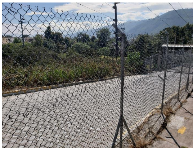
Foto cerramiento norte y vía de acceso
