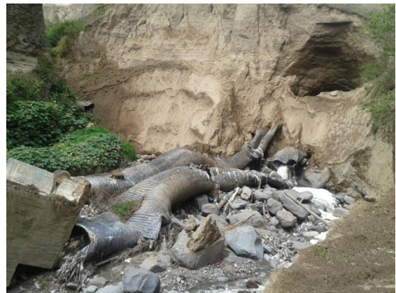
10. Colapso de Alcantarilla vial – Av. Simón Bolívar – cauce qda. Chaquiscahuaycu -2013
