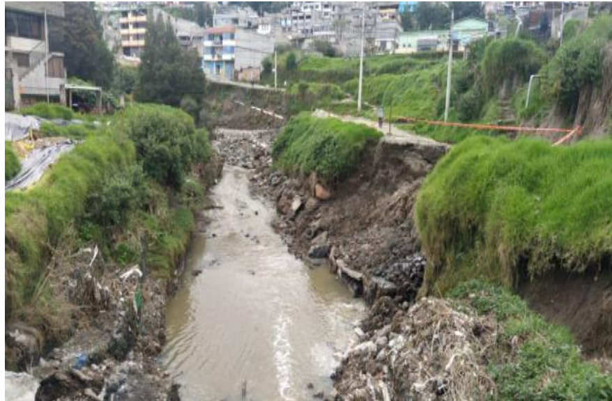
9. Corrección fluvial cauce río Machángara – Sector Puente Susana Letor
