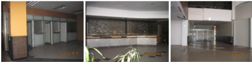
En condiciones más deterioradas se encuentran las áreas en la planta alta, mismas que cuentan con múltiples oficinas, baños, cocina, salones de reuniones, entre otros; se evidenció la existencia de humedad en las paredes y pisos, planchas de gypsum rotas, cables sueltos, alfombras levantadas y deterioradas, vidrios de las ventanas rotas, y más; observaciones que muestro en las siguientes imágenes:
