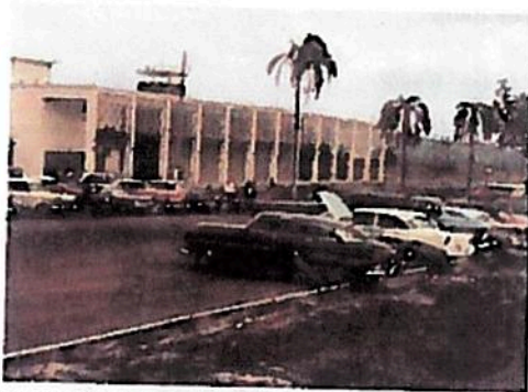
Fotografías de la Terminal Aérea Original, año 1960
