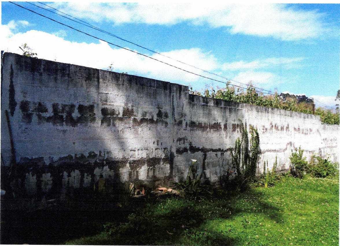
PROPIEDAD UBICADA EN LA CALLE CAPULI, PARROQUIA AMAGUAÑA.
