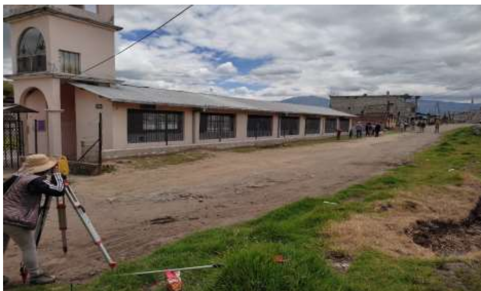
Fotografía 3. Socialización técnica- verificación de laterales de la vía
