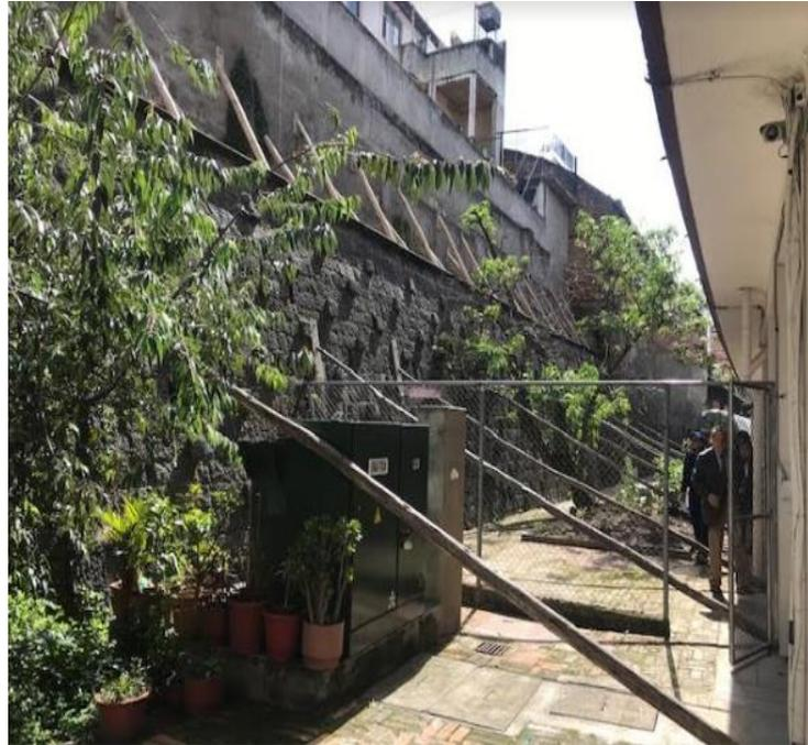
Para realizar la intervención del mejoramiento y estabilización de este muro, se realizó una consultoría, que permitió identificar y obtener los productos técnicos de ingeniería necesarios sobre las obras a realizarse, para determinar la mitigación y/o reforzamiento estructural.
