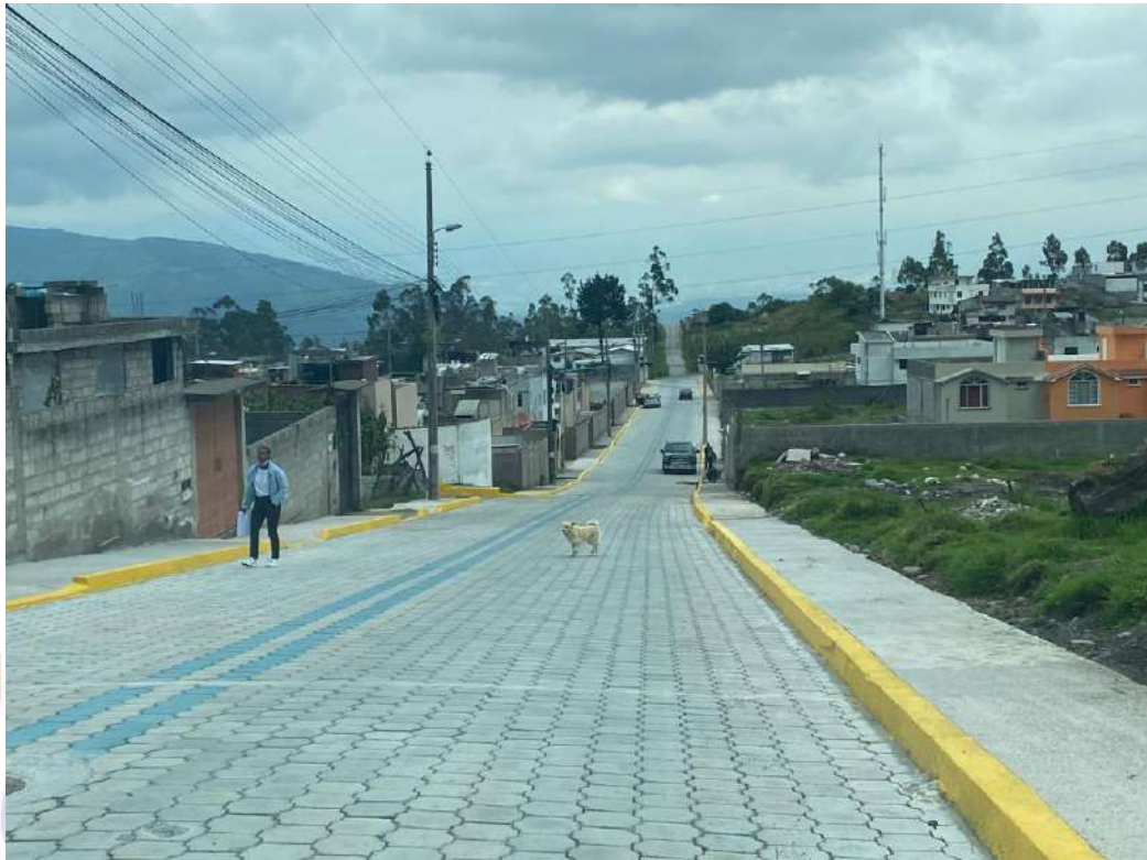
FOTOGRAFÍA 1: Calle Alejandro Galarza adoquinada.
