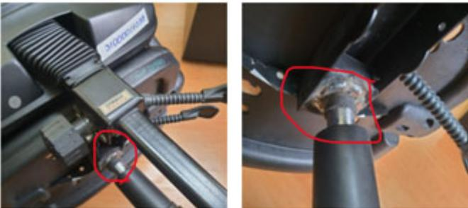
Sillas reparadas con suelda ya en mal estado
