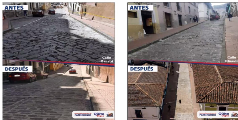
Intervención integral en calzadas de piedra
