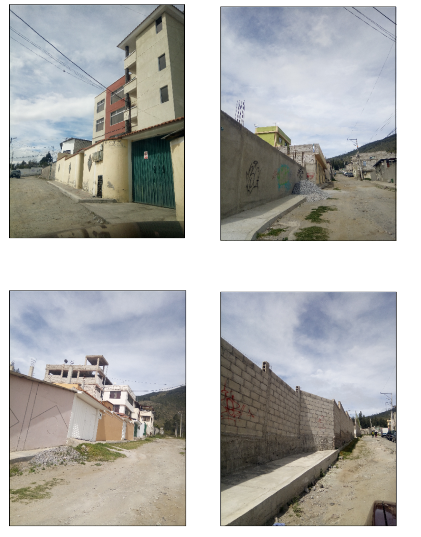
FOTOS ESTADO ACTUAL
