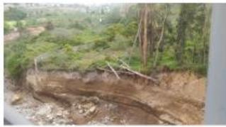
**Foto No. 4:** Árboles al borde superior de talud, por caer generan inestabilidad talud.
