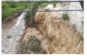
**Foto No. 2:** Inestabilidad de taludes, erosión hídrica, afectación a predios
