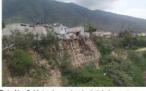
**Foto No. 3:** Viviendas en borde de talud superior y descargas informales.
