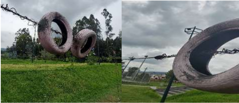
Sistema de tarabita a punto de colapso
