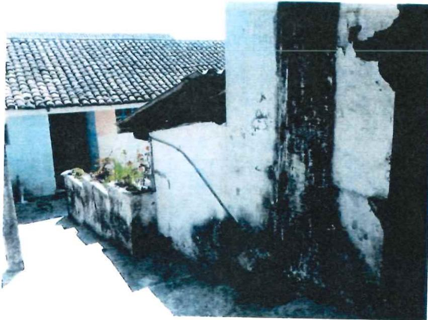
Falta de mantenimiento en estructura de cubiertas.
