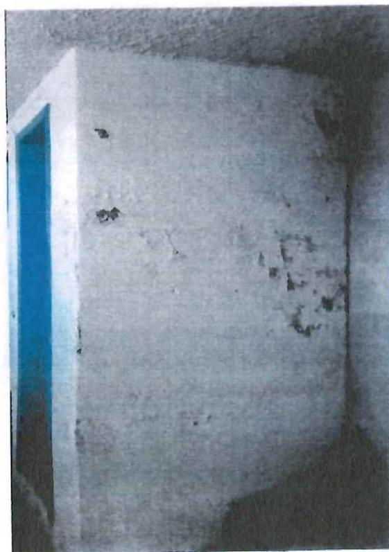
Se pueden apreciar varias tejas rotas y movidas, humedad en muros y desprendimiento de enlucidos.
