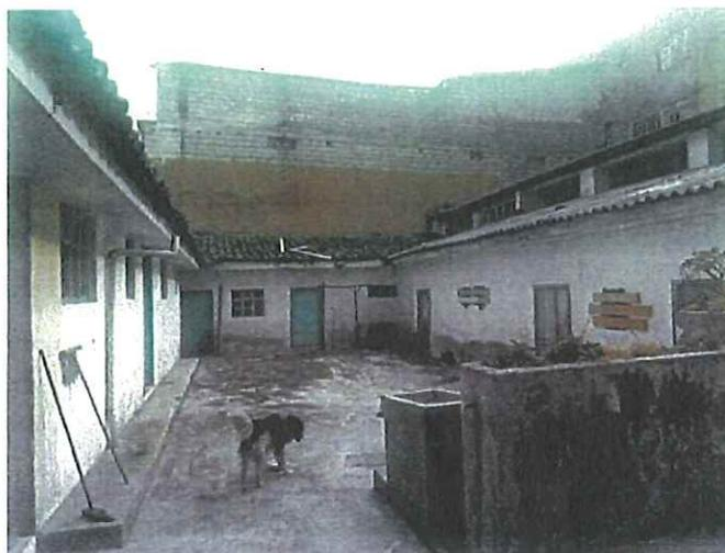
En la edificación que tiene placa de fibrocemento, hay sectores que están completados con pedazos de placa de fibrocemento para cubrir los faltantes de la cubierta, no tiene canales ni bajantes de recolección de agua lluvia.
