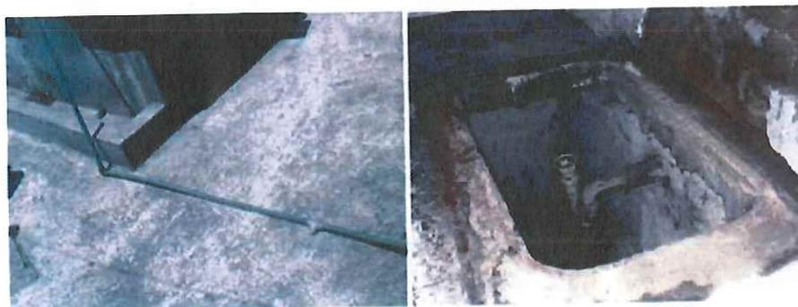
Tuberías expuestas y evidencia del desmantelamiento del sistema sanitario
