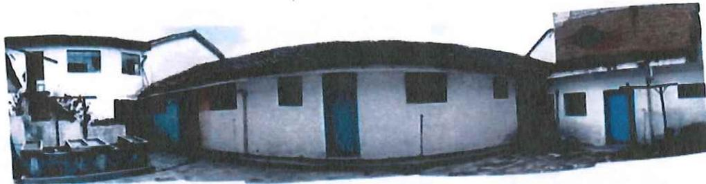
Imágenes panorámicas del "patio interior" del inmueble. Puede observarse en ellas las cubiertas de teja de barro y de planchas onduladas de asbesto cemento, así como el pavimento de cemento, cargado de moho en los bordes debido a la humedad. También puede observarse la clara estructura de implosión en celdas adaptada al inquilinato.
