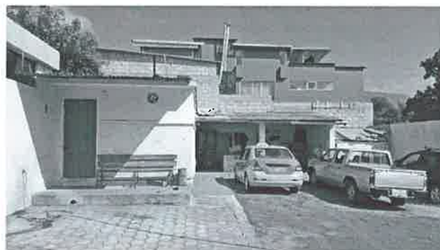
Fotografías de Inspección
