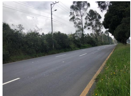
Fotos 12: sector de empate en la Av. Simón Bolívar
