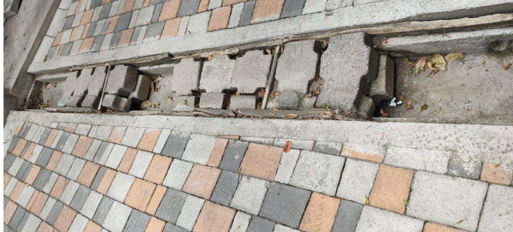
SUMIDERO DE PISO (COLOCACIÓN DE REJA)
