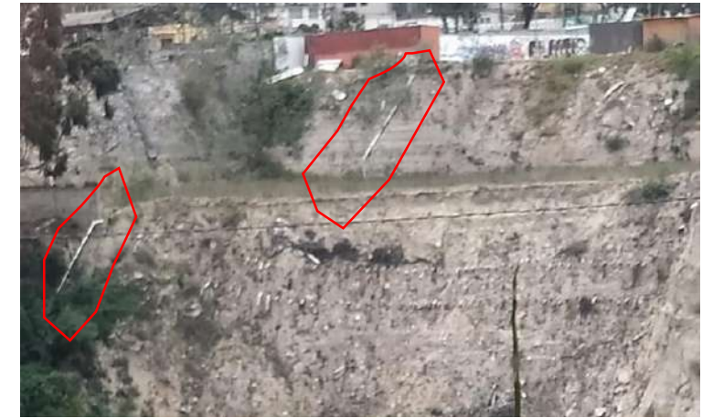
Foto No. 3: Descargas informales directas al cauce
