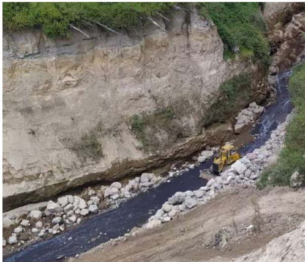
Foto No. 1: Sector La Esperanza, colocación de piedra en las márgenes de la quebrada el Colegio, junio 2021.
