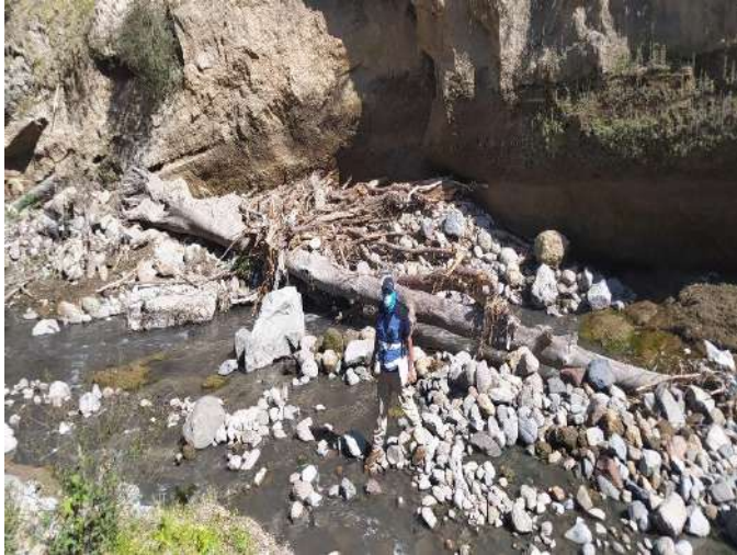
Foto No. 1: Elementos estructurales de muros y árboles colapsados en cauce.
