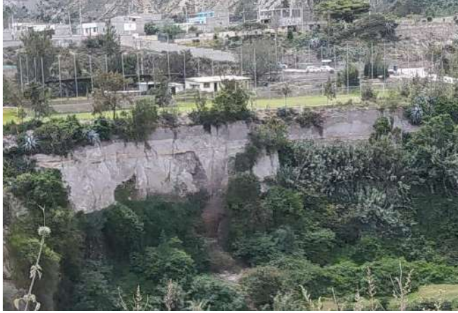
Foto No. 1: Inestabilidad de talud en margen derecho afectaría Canchas de Liga deportiva de San Antonio de Pichincha.
