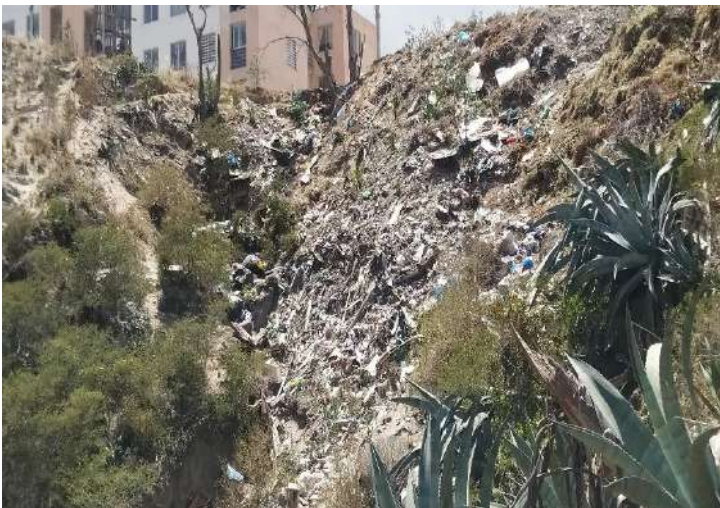
Foto No. 2 Botadero de escombros desde ciudad Bicentenario hacia la quebrada Curiquinge.
