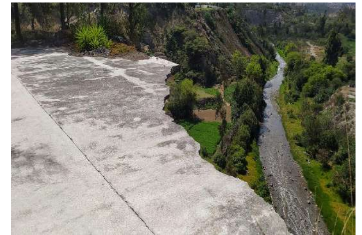
Foto No. 4: Cancha recreativa sin base debido a deslizamientos de talud
