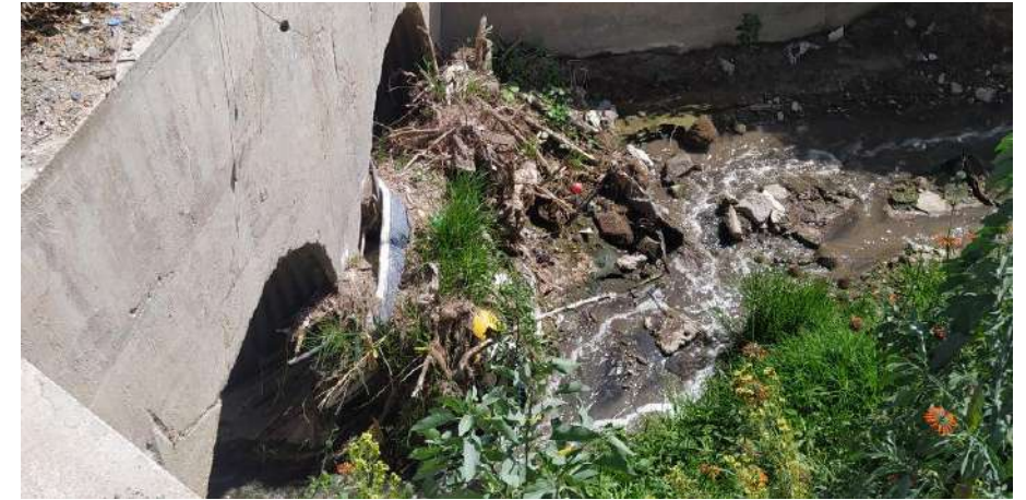
Foto No. 3: Taponamiento de vía colectora, zona de inundación.
