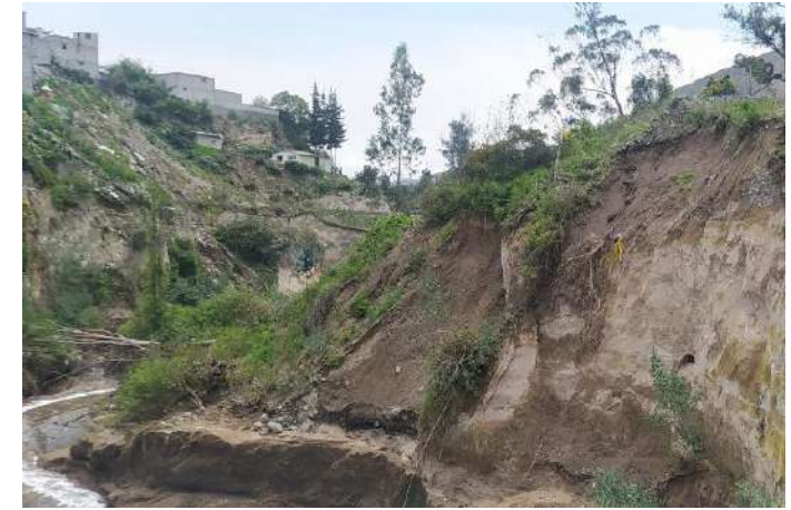
Foto No. 3: Inestabilidad en taludes, afectación a infraestructura pública (vía, pozo vórtice, sistema de alcantarillado)
