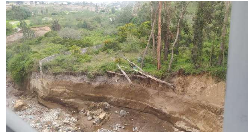
Foto No. 4: Árboles al borde superior de talud., por caer generan inestabilidad talud.
