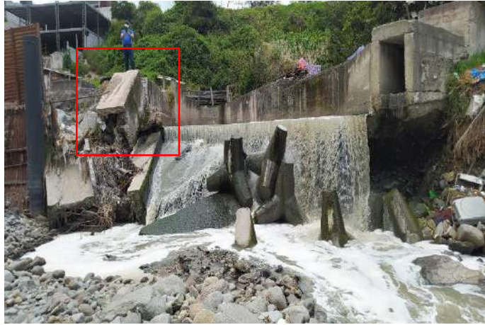
Foto No. 1: ala estructura de EPMAPS parcialmente colapsada
