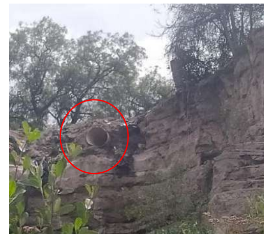
Foto No. 4: Prolongación del colector de descarga al talud
