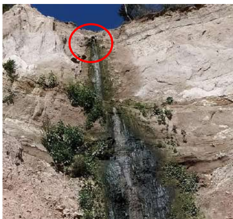
Foto No. 2 descargas informales al talud
