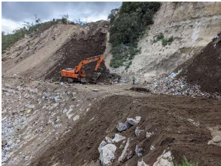
Foto No. 2: Barrio La Independencia, colocación de piedra y formación de plataforma, julio 2021
