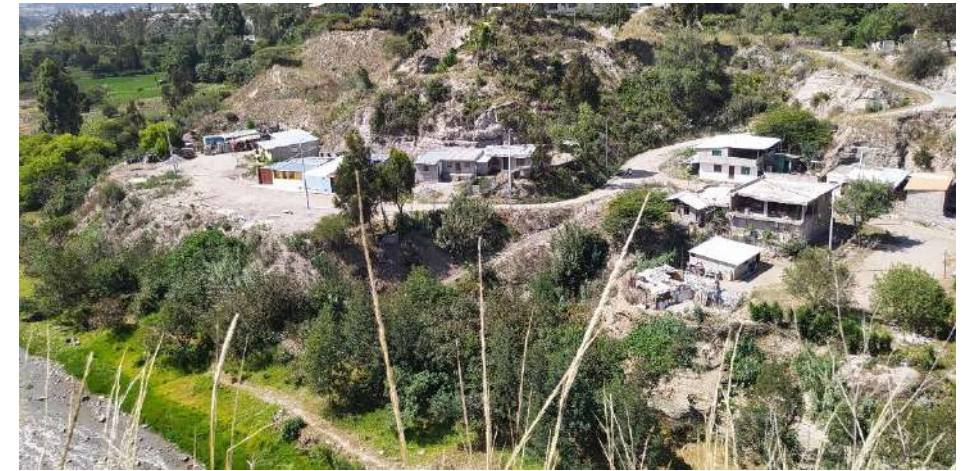
Foto No. 3: Relleno antitécnico para asentamientos informales en la margen izquierda del río (AHHC Jesús Bolaños)
