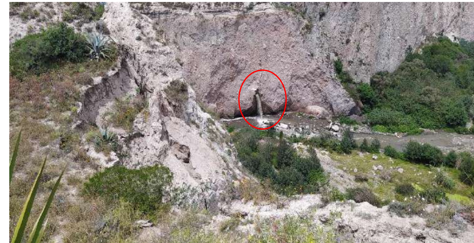
Foto No. 4: descargas directas al cauce
