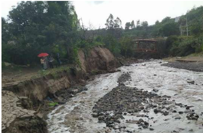
Foto No. 2 Zona de inundación, margen izquierda
