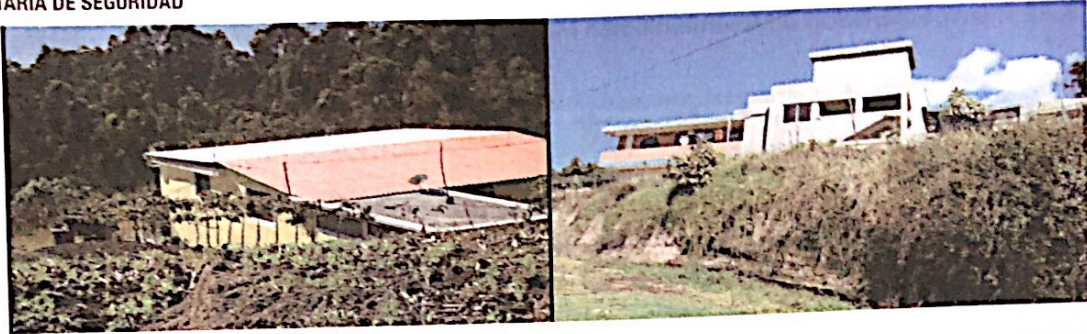
8.1.3 Servicios basicos en el sector existentes
