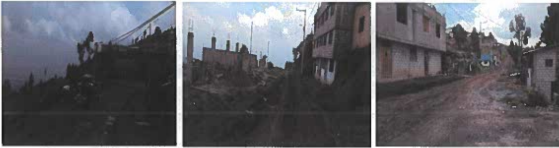
8.1.2 Materiales de las edificaciones construidas alrededor del area en estudio.
