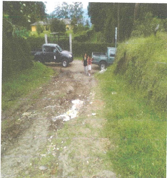
Inicio vía (tramo 1)
