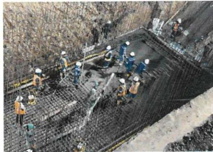
**Foto 14.** Acero de refuerzo en piscina de lixiviados y hormigón de losa de cimentación
