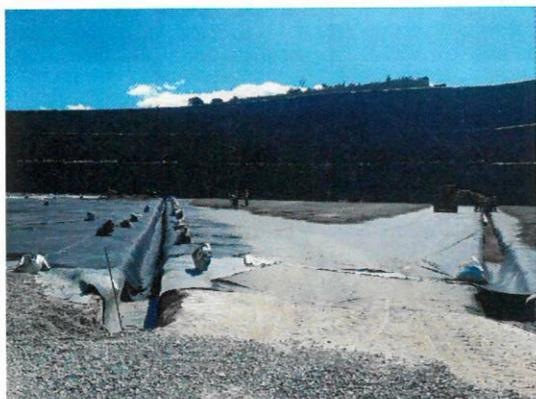
**Foto 5.** Cobertura con material pétreo para impermeabilización
