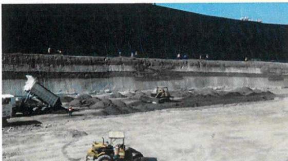
**Foto 13.** Conformación de la barrera geológica
