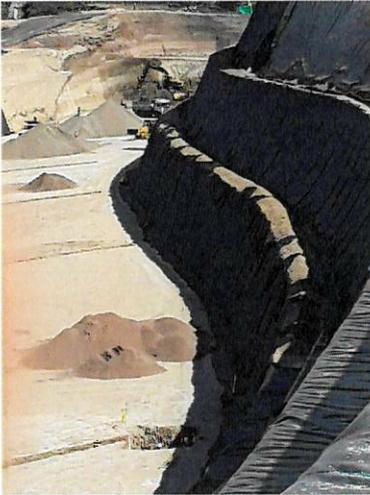
**Foto 7:** Instalación de geomembrana y geotextil
