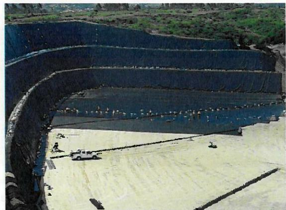
**Foto 12.** Instalación de geotextil y geomembrana en taludes
