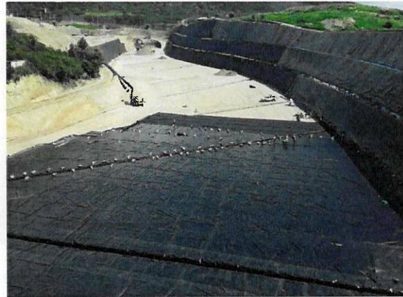
**Foto 10.** Instalación de geotextil y geomembrana en base del cubeto
