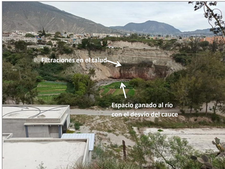
Imagen No. 15 Vista de la modificación del cauce del río, Inestabilidad causada al talud y filtraciones de agua
