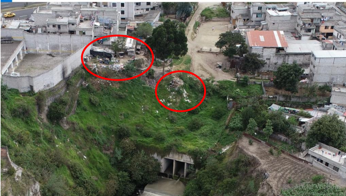
Imagen No. 5 Acumulación de residuos sólidos /basura
