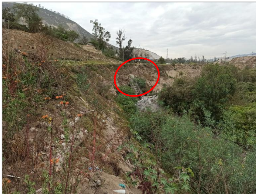
Imagen No. 11 Relleno sector Contraloría y descarga EPMMOP
