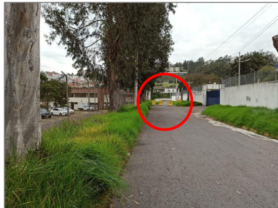
Imagen No. 4 Tramo de la calle cerrada provisionalmente con muros Jersey
