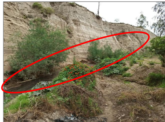
Imagen N. 10 Vista del cauce actual de la quebrada
