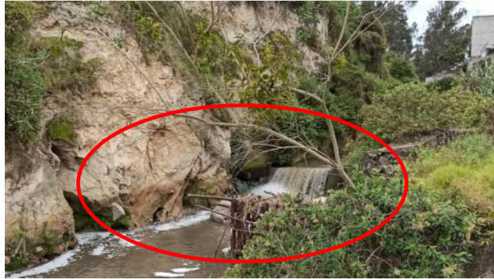
Imagen No. 7 Obra de protección, cruce de tubería de agua
