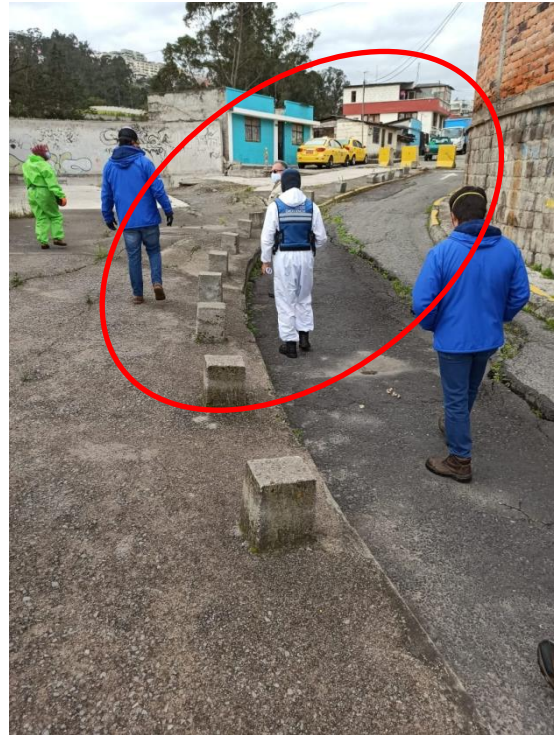
Imagen No. 2 Vista del asentamiento de la calle y las casas en peligro
