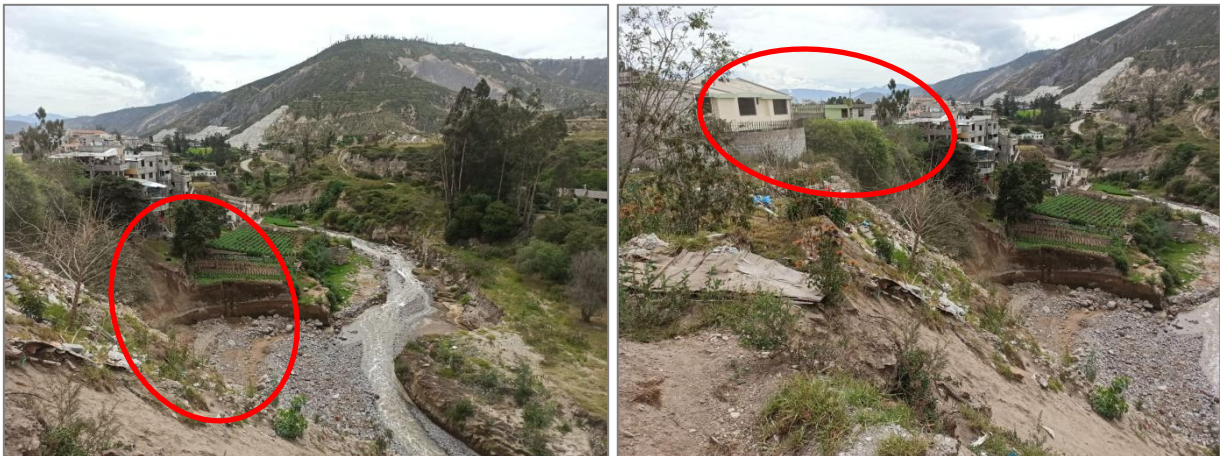
Imagen N. 16 y 17, vista de la acción erosiva del río, deslizamientos del talud y casas en riesgo
