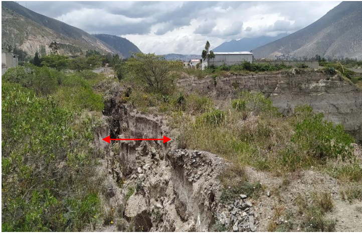
Foto No. 1: Grietas en superficie de la margen derecha del río
