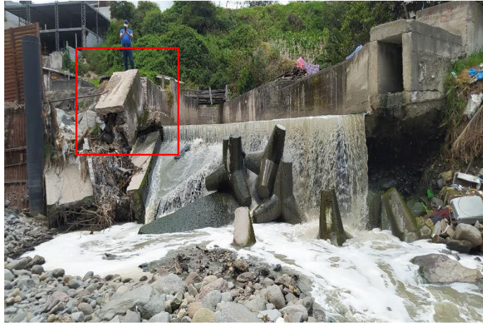
Foto No. 1: ala estructura parcialmente colapsada
