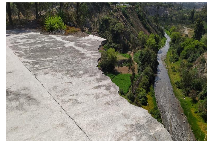
Foto No. 4: Cancha recreativa sin base debido a deslizamientos de talud
