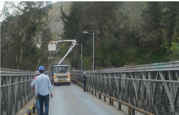
Foto No. 1: Estado actual y reforzamiento de puente la Marqueza.
