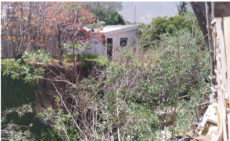
Foto No. 1: Viviendas en borde superior de quebrada.
