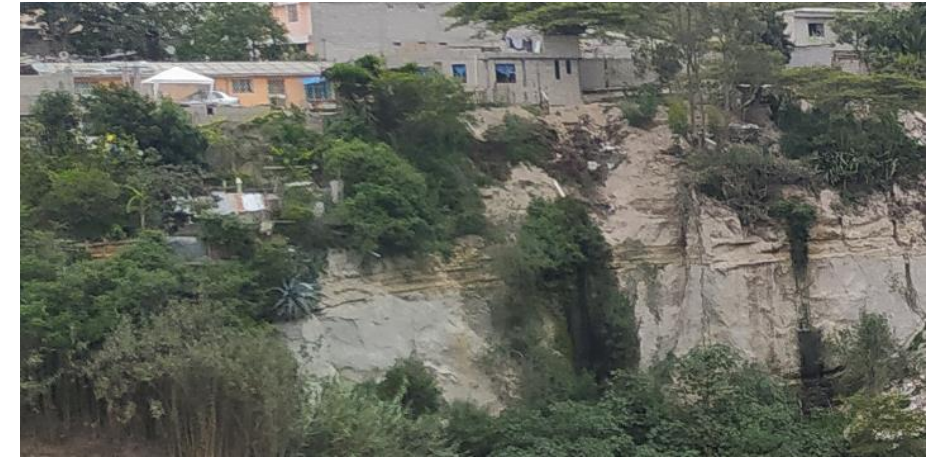
Foto No. 3: Viviendas al borde del talud.
