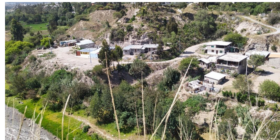
Foto No. 3: Relleno antitécnico para asentamientos informales en la margen izquierda del río (AHHC Jesús Bolaños)
