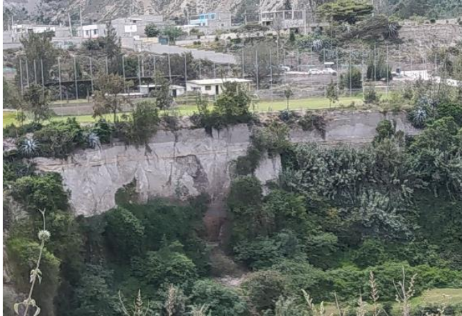
Foto No. 1: Inestabilidad de talud en margen derecho afectaría Canchas de Liga deportiva de San Antonio de Pichincha.
