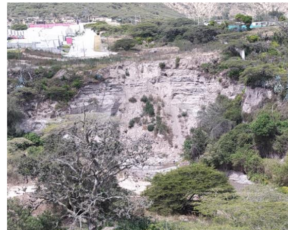
Foto No. 3: Botadero de escombros y basura al cauce.
