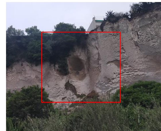
Foto No. 3: Inestabilidad de talud, erosión eólica.
