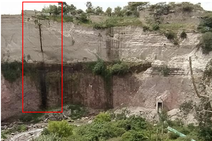
Foto No. 2 Descargar informales y saturación del suelo y viviendas en franja de protección.
