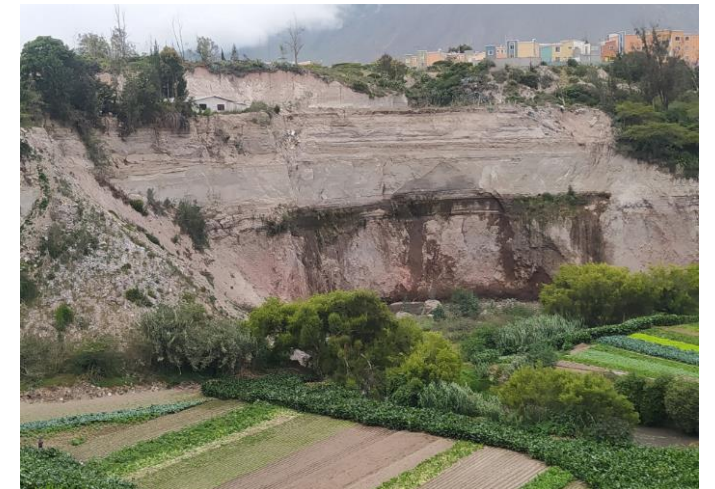
Foto No. 4: Inestabilidad de talud, erosión hídrica y eólica.
