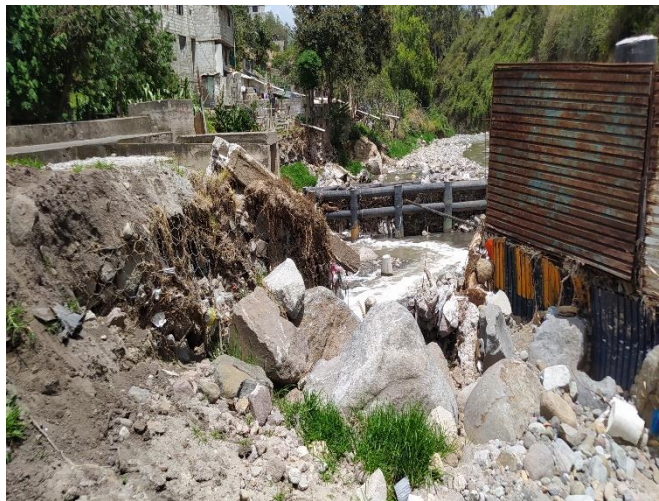
Foto No. 1: ala estructura parcialmente colapsada
