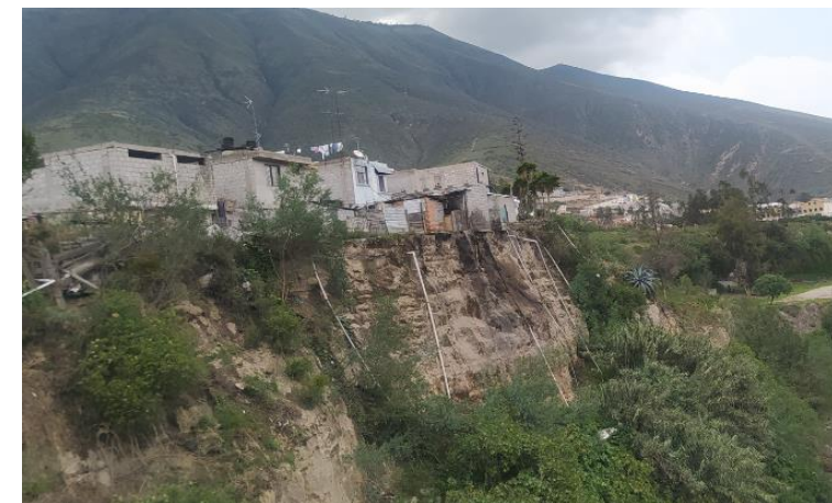
Foto No. 3: Viviendas en borde de talud superior y descargas informales.
