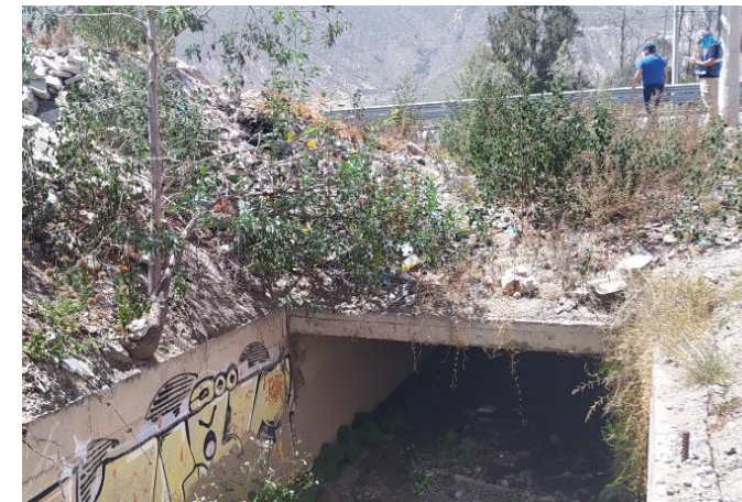
Foto No. 3: Posible taponamiento en estructura hidráulica.
