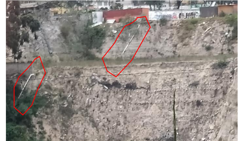
Foto No. 3: Descargas informales directas al cauce
