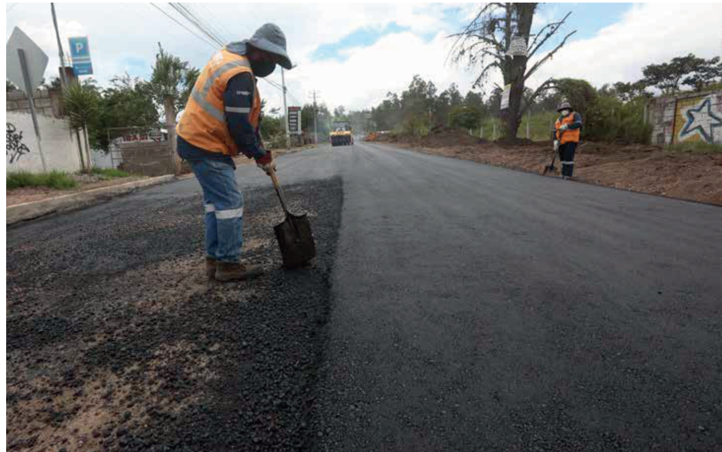
Av. Ilaló (Tramo 2) (Avance 80%)
