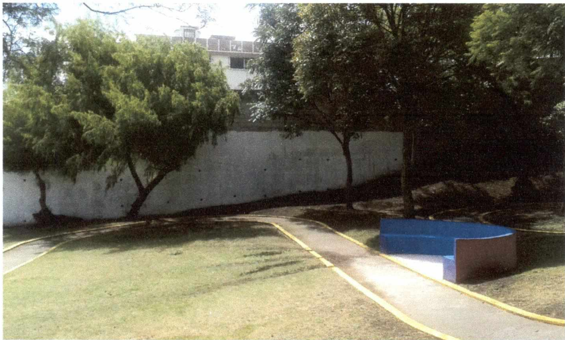
FOTOGRAFIA N° 6: MUROS DE CERRAMIENTO SUR DE AREA COMUNAL
