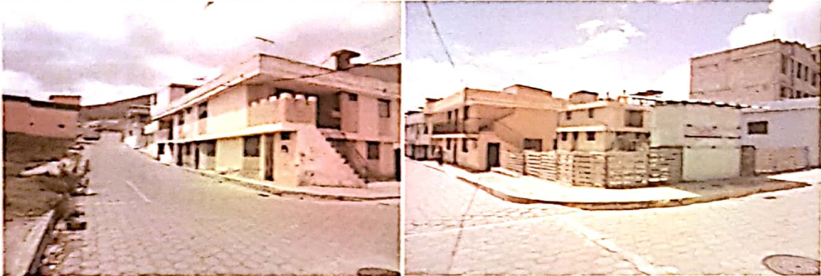
8.1.3 Corte de terreno y servicios basicos para el manejo de agua de escorrentia
