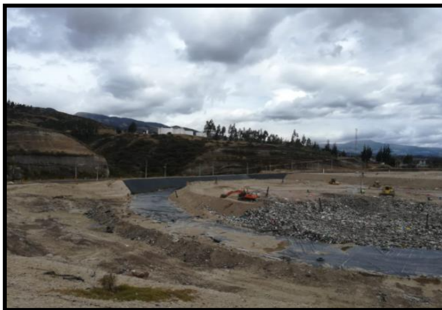
Figura 5.- Manejo de frentes diarios en el cubeto 9 fase B, actualmente operativo
