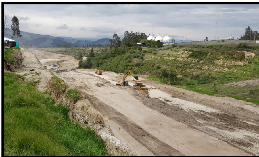
Figura 2. Equipo Técnico EMGIRS-EPMMOP inicios de obra del área del cubeto Nro. 10
