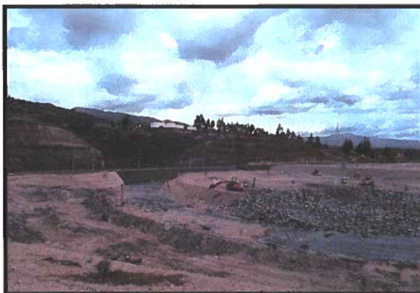
Figura 6.- Manejo de frentes diarios en el cubeto 9 fase B, actualmente operativo
