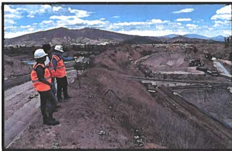
Figura 2. Equipo Técnico EMGIRS-EPMMP inicios de obra del área del cubeto Nro. 10
