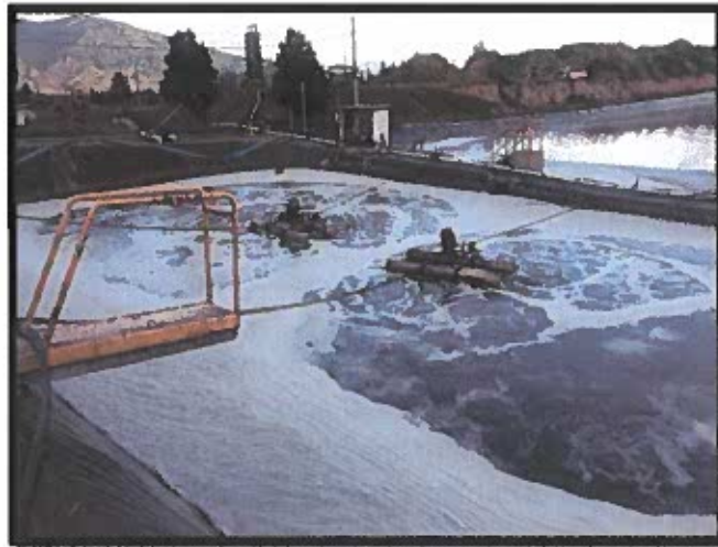
Figura 5.- Proceso de aireación en la piscina 1 del Relleno Sanitario “El Inga”
