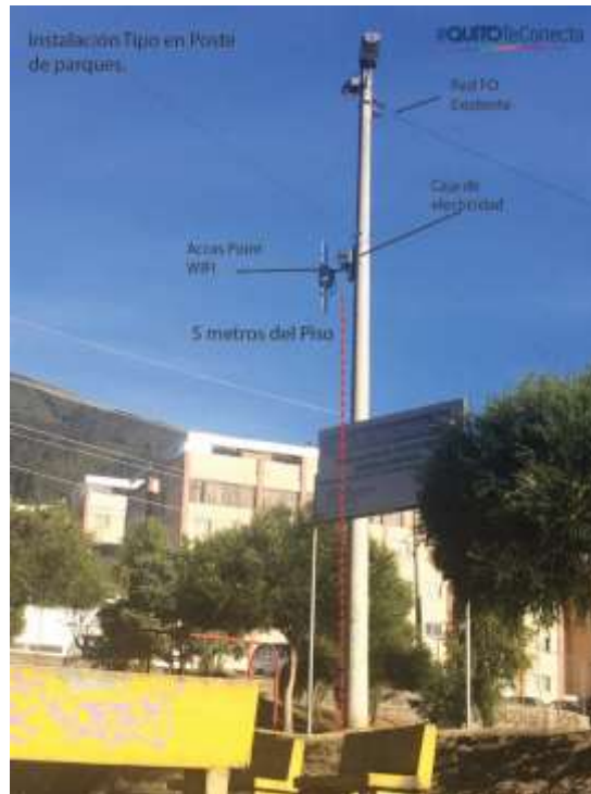
Ejemplo de cómo se realizó la Instalación de puntos en Poste de luz en Parque Altamira.
