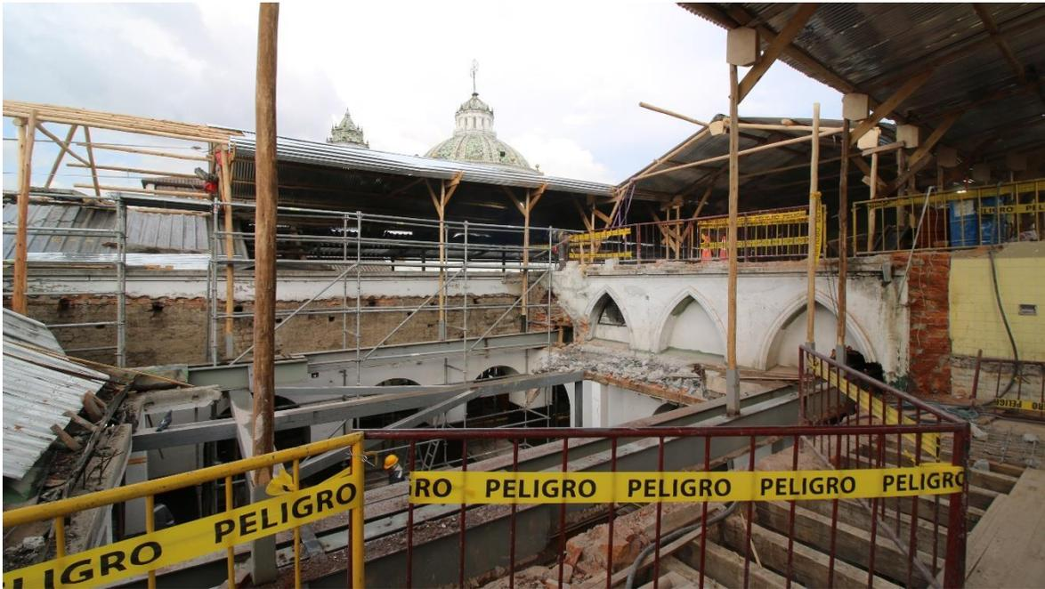
*Vaciado del interior, con estructura metálica de apeo*
