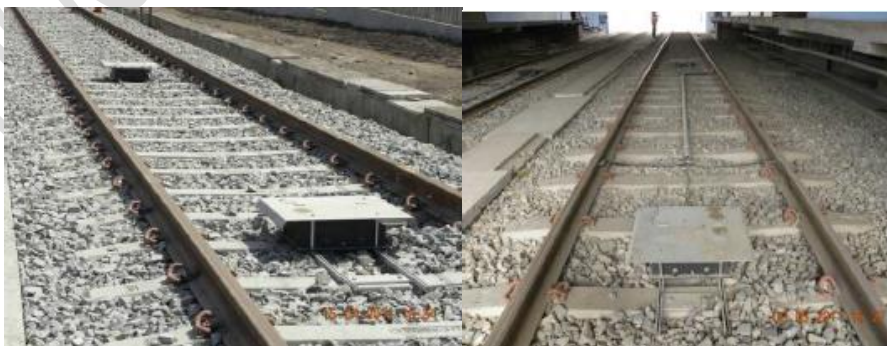
Figura 6 Circuitos de Vía
