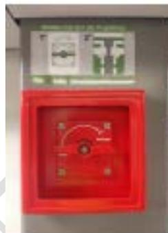
*Figura 7 Dispositivo de desbloqueo interior de emergencia*
