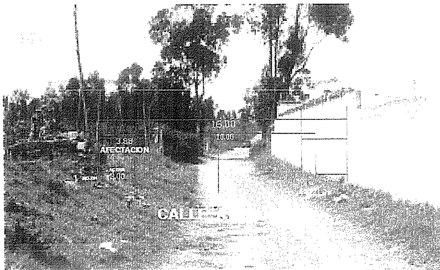
FOTO 1.- CALLE ATAHUALPA 16.0m. (vista de norte a sur) AFECTACION VARIABLE DE 4.66 m al lado Oeste y 3.88 m al lado Este puntos de referencia: Eje vial y Cerramiento existente
