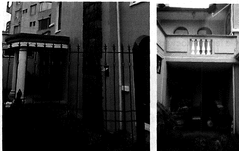
Vista General de construcción adosada.
