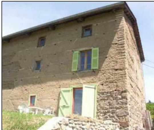
**Ilustración 2** Imagen referencial de una edificación con estructura de tapial
