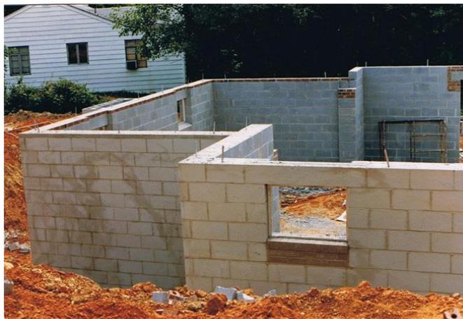
*Ilustración 1* Imagen referencial de una edificación con estructura de bloque
