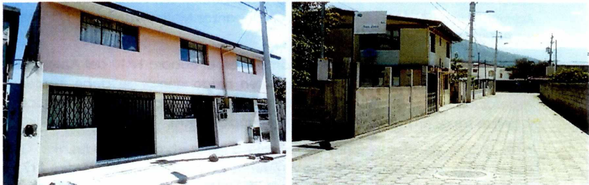
8.1.3 Corte de terreno y servicios básicos para el manejo de agua de escorrentía.
