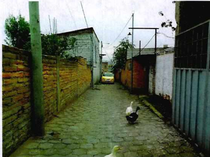
Foto 4 Pasaje Peatonal S46C
