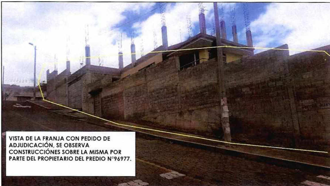
VISTA DEL PREDIO N°96977 DESDE LA CALLE ZUMBA
