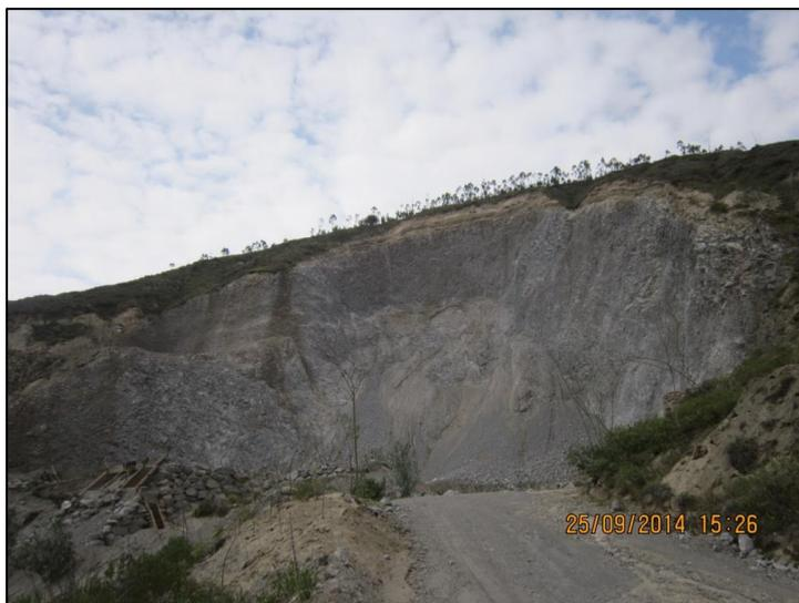
*Cantera El Corazón, sin un cierre técnico adecuado; se pueden generar caídas de bloques y flujos de escombros por remoción de escombros*
