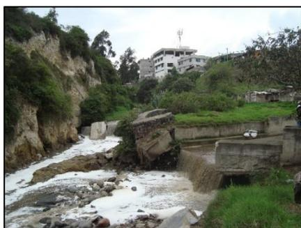
*Muros de gaviones que se encuentran destruidos y volcados debido a socavación del cauce y la erosión retrocedente. Diques transversales estabilizadores construidos en el cauce del río, los cuales también se encuentran en proceso de desestabilización debido a la erosión y a la profundización del cauce.*
