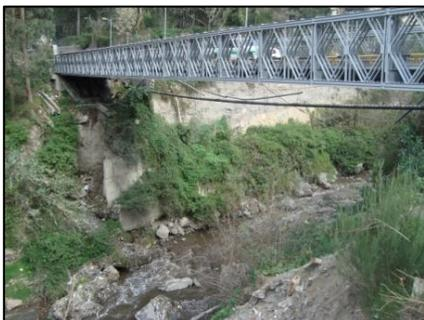
*Muros de hormigón para protección de las pilas del puente en las dos orillas, se observa socavación y profundización del cauce y destrucción de obras construidas para protección del puente.*
