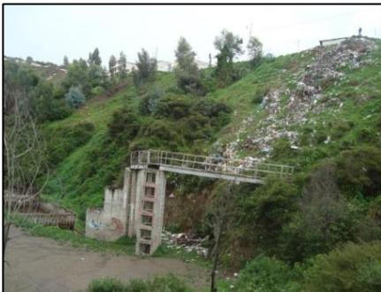
*Obra de control de inundaciones y retención de sedimentos (presa de tierra) provista de dos filas de rejillas para retener materiales grandes. Se ha convertido en botadero de basura.*
