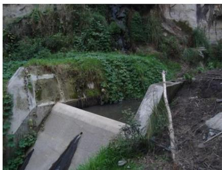
*Canal ancho de hormigón que direcciona el cauce de la quebrada, provisto de un vertedero que sirve para laminar pequeñas crecidas y retener sedimentos. Existe un crecimiento de maleza y árboles en el cauce de la quebrada y contaminación por aguas servidas, produciéndose un impacto ambiental.*
