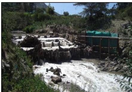
*En este sector cruza por el fondo del río la tubería del oleoducto de crudos pesados – OCP, para su protección se han construido pantallas con láminas de acero fijadas a pilotes de hierro y se han construido además diques transversales que permiten proteger de la erosión y/o socavación del cauce.*
