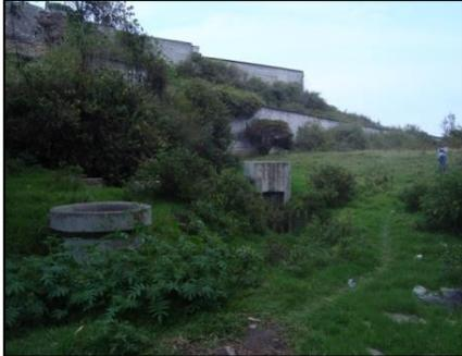
*Dique o pequeña presa de tierra para regulación o laminación de crecidas y retención de sedimentos con una estructura provista de una rejilla para captar agua de crecidas y evacuar hacia la margen izquierda de la quebrada.*
