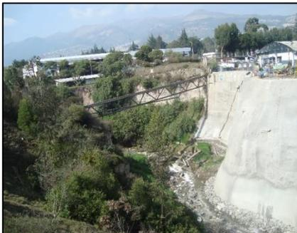
*Muros de hormigón armado y taludes impermeabilizados con hormigón lanzado en la margen izquierda del río, protegidos con pequeños muros de gaviones y piedras acomodadas. Se observan bloques de muros de hormigón fallados en el cauce del río. Por este sector cruza una tubería de agua potable para el sector de Pomasqui.*
