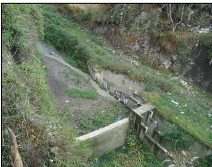
*Pequeña obra de regulación o laminación de crecidas y retención de sedimentos con canal lateral de derivación de caudales hacia la orilla izquierda. Existe azolvamiento de sedimentos y basura en la estructura, con una fuerte erosión de las márgenes del cauce. Botadero de basura.*
