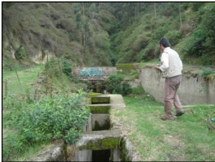
*Presa (dique) de regulación o laminación de crecidas y retención de sedimentos con un vertedero de excesos y una rejilla colocada aguas abajo, que permite captar agua y mediante un canal depositar en un reservorio de regulación que se conecta con el alcantarillado de la ciudad.*
