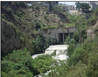
*Estructura hidráulica de hormigón armado con tres módulos de salida de caudales que desembocan en la quebrada El Colegio, aguas abajo existen disipadores de energía. En general las obras se encuentran en buen estado, excepto los disipadores que se encuentran en proceso de deterioro por efectos de socavación y erosión retrocedente del río.*
