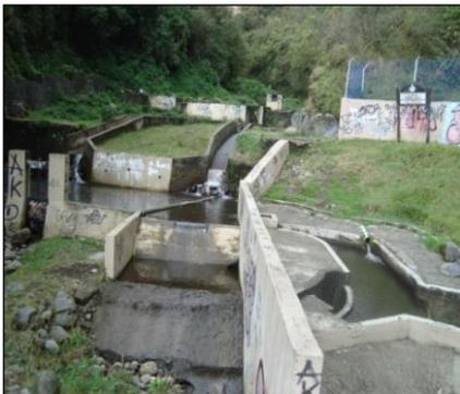
*Sistema Noroccidente de captación de agua potable. Se trata de una toma de fondo (caucasiana) que capta la totalidad del agua de la quebrada. Aguas arriba de la toma no existe intervención antrópica.*
