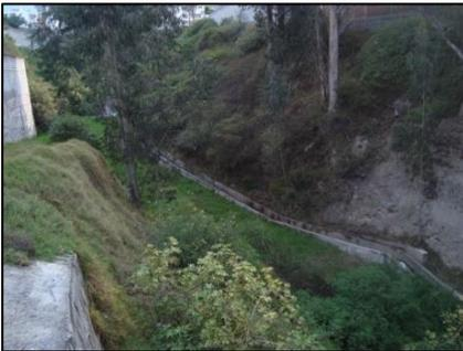
*Obras derivadores de caudales sanitarios y pluviales construidos en la margen izquierda de la quebrada, que llega hasta una captación de caudales, provista de una rejilla de hormigón a la cual confluyen aguas servidas que llegan del canal y la quebrada.*
