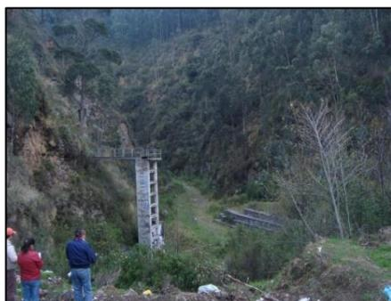
*Presa de tierra para para regulación o laminación de crecidas y retención de sedimentos con una estructura provista de ventanas y rejillas a diferente altura para captar crecidas y evacuar hacia la margen izquierda de la quebrada. Muros de gaviones para proteger la orilla izquierda de la quebrada.*
