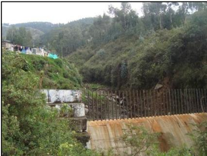
*Pequeña presa o dique de regulación o laminación de crecidas y retención de sedimentos, cuya estructura (rejillas y vertedero) permite laminar crecidas, retener sedimentos y material flotante, para dejar pasar solo el caudal líquido. Construcciones informales cerca del dique*
