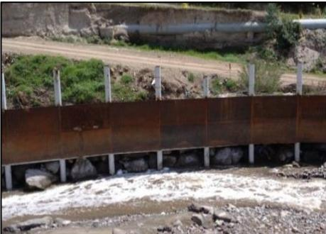
*Pantallas con láminas de acero empotradas a pilotes de hierro, que permiten proteger la tubería de aguas servidas que pasa cerca a la orilla derecha del río. Esta obra de mitigación no está dando los resultados esperados, debido a que el diámetro de la roca que conforma la escollera es menor a la separación entre pilotes.*
