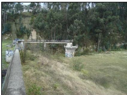
*Presa de regulación o laminación de crecidas y retención de sedimentos con un vertedero tipo vórtice que permite derivar el caudal hacia la orilla izquierda. Altura de muro de la presa de 3,50 m aproximadamente. Las estructuras se encuentran en buen estado. Cancha deportiva en el vaso de la presa.*
