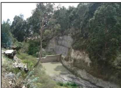
*Dique de regulación o laminación de crecidas con rejillas para retención de sedimentos y basura con un canal lateral de evacuación de caudales colocado en la margen izquierda de la quebrada.*
