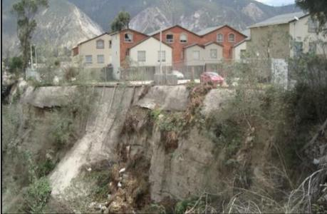
*Taludes impermeabilizados en proceso de destrucción y fallados. Necesitan reconstrucción por parte de los propietarios de la Urbanización*
