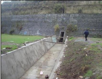
*Presa de regulación o laminación de crecidas y retención de sedimentos con un canal trapezoidal (2x2) transversal al vaso de la presa, una captación de caudales a diferentes alturas provisto de rejillas, que conecta a un canal lateral ubicado en la orilla izquierda. A esta presa llega una conducción de aguas tipo galería. No se observa alteración de la cuenca.*
