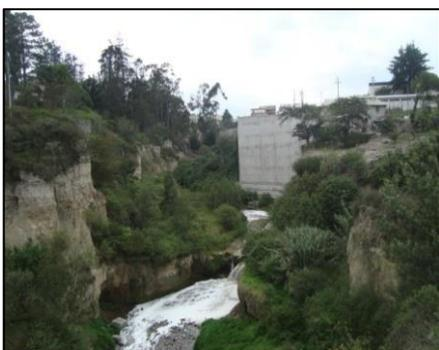
*En la margen izquierda de la Q. El Colegio (Río Monjas) se ha construido un muro de 30 m de altura aproximadamente para proteger las viviendas e industrias ubicadas en esa margen del río. Se observan muros de hormigón volteados en la mitad del río, producto de anteriores crecidas.*
