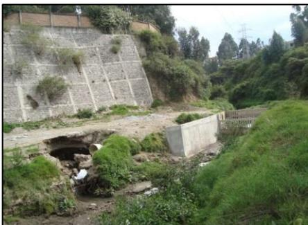
*Presa de tierra para regulación y/o control de crecidas y sedimentos, cuenta con dos estructuras de evacuación de caudales a diferentes alturas con seis ventanas y sus respectivas rejillas. La ubicación de las salidas de las alcantarillas no es la correcta como se observa en la Fotografía.*
