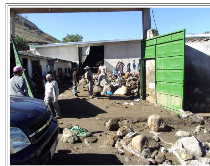
Fotografía. Daños generados por el flujo de escombros en Santa Rosa de Pomasqui, el 18 de octubre del 2013.
