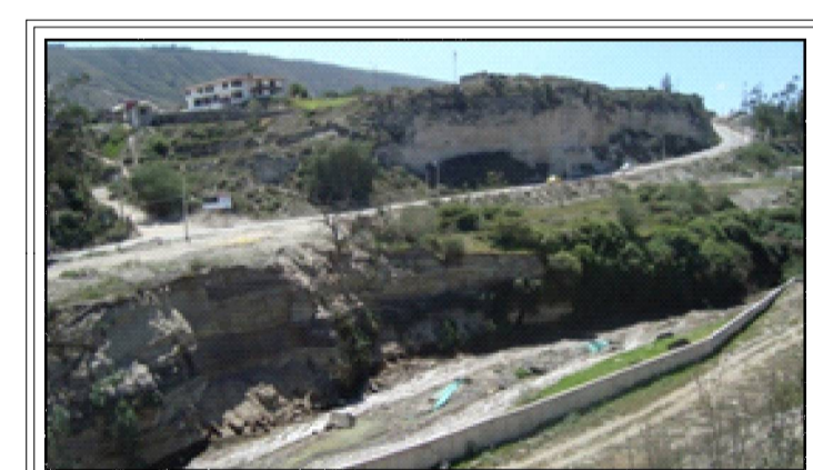
Fotografía. Avance regresivo del talud en la margen derecha, debido a la acción hídrica que genera socavación horizontal y vertical y como consecuencia fenómenos de remoción en masa. (Derrumbes, caída de bloques, deslizamientos).
