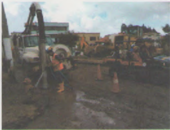
LIMPIEZA DE SUMIDEROS EN LAS VÍAS DEL PINAR Y BARRIO OSORIO fotografías # 13
