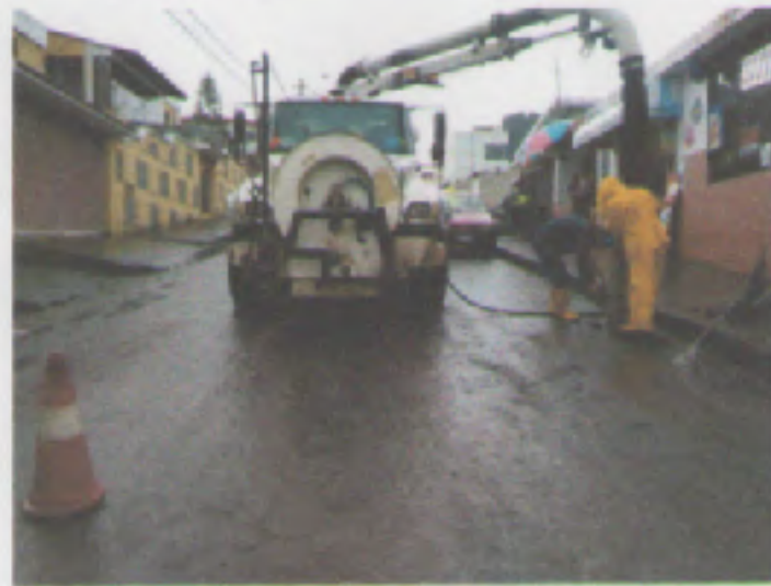
LIMPIEZA DE SUMIDEROS EN LAS VÍAS DEL PINAR Y BARRIO OSORIO fotografías # 13
