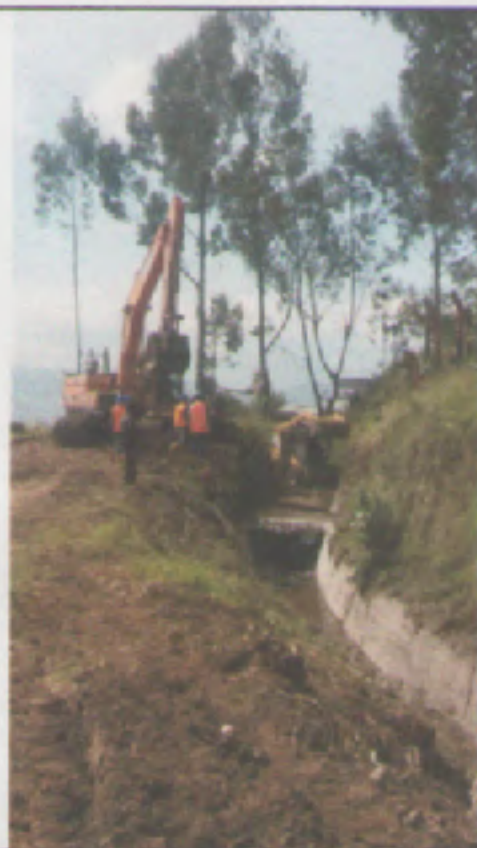
TRABAJOS DE DERROCAMIENTO DE SECCIONES SOBRE EL CANAL fotografías # 11
